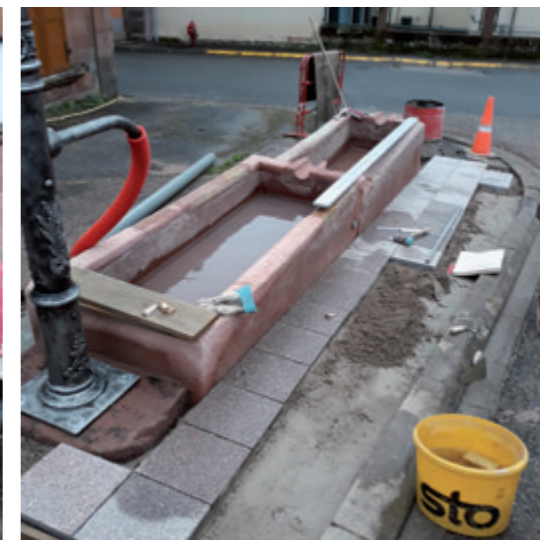
12 décembre : Réinstallation des bacs et de la colonne
