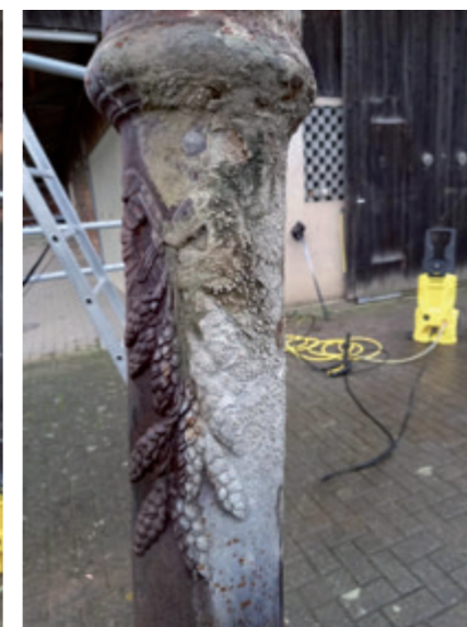
1 er décembre : Décapage
