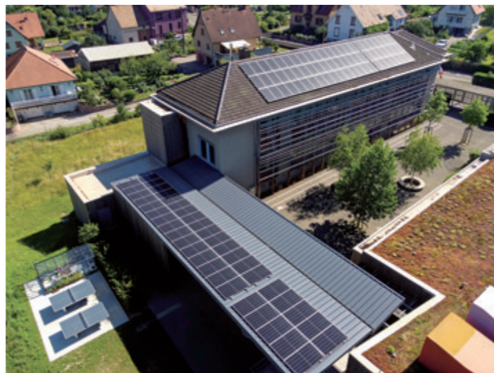
Installations solaires de l'Ecole de Dossenheim/Zinsel
