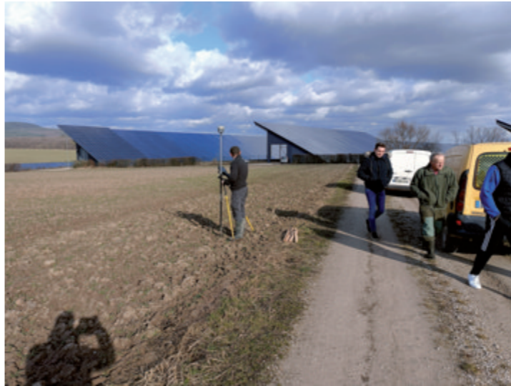
Le piquetage pour la future antenne-relais au lieu-dit Spenweiler a été réalisé par un géomètre. La déclaration de travaux a été déposée et validée. Les travaux pourront démarrer dès que l'Association foncière aura donné son accord pour la servitude de ses chemins.
