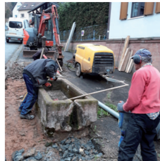
30 novembre : Démontage des bacs
